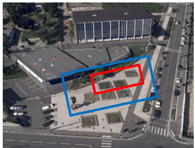
FIGURE 7 - VUE AERIENNE DES DISPOSITIFS DE STOCKAGE (BLEU) ET DES DISPOSITIFS DE DEPOLLUTION (ROUGE) (SOURCE : DEA)
