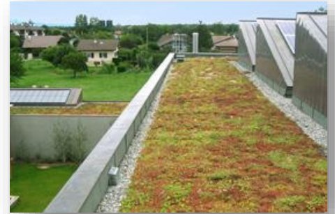
FIGURE 3 - TOITURE VEGETALISEE (SOURCE : ECOVEGETAL.FR)
