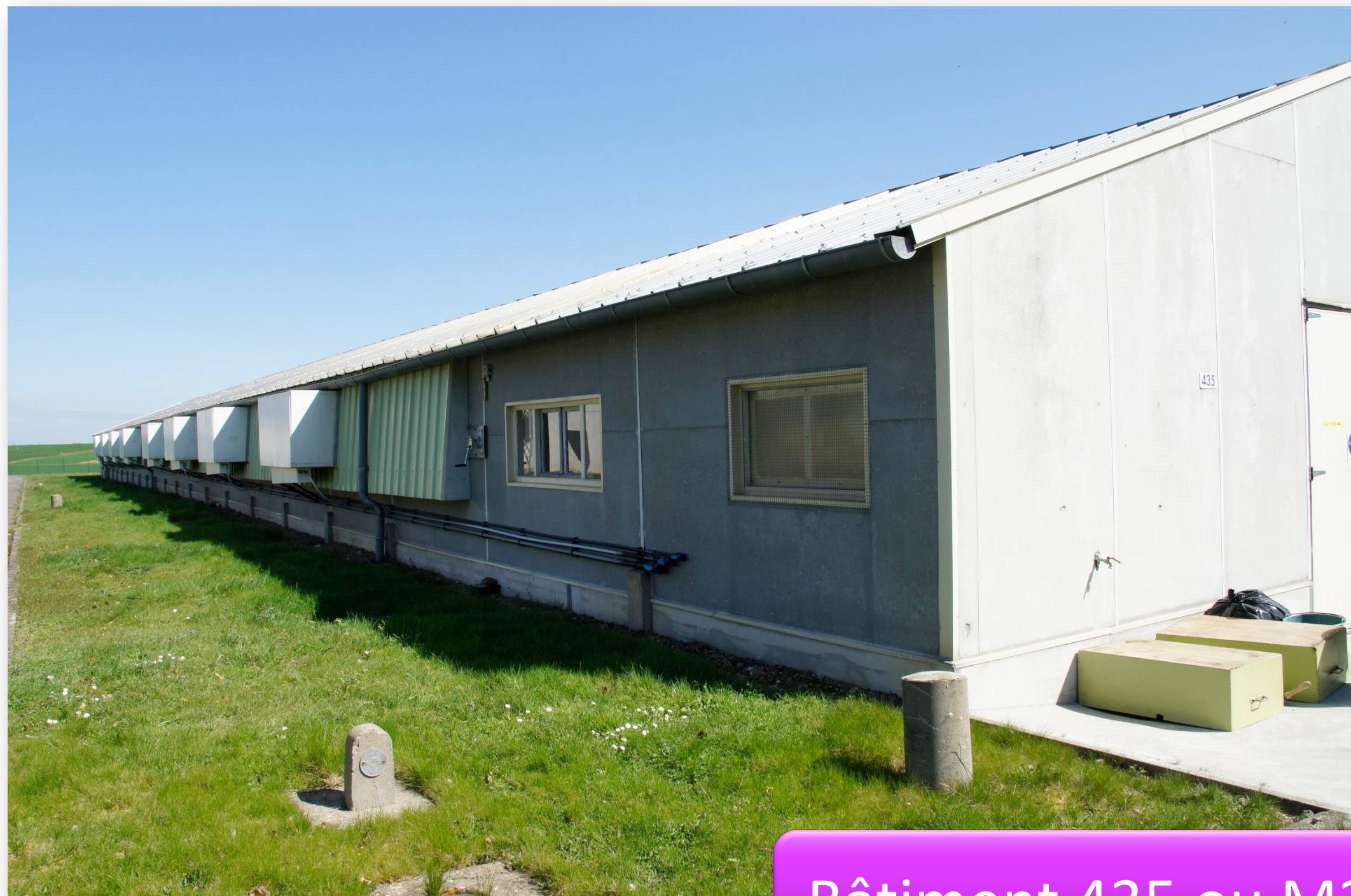
Bâtiment 435 ou M2
