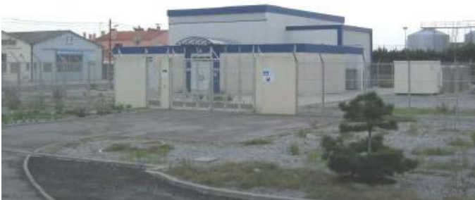
Poste source en intérieur
