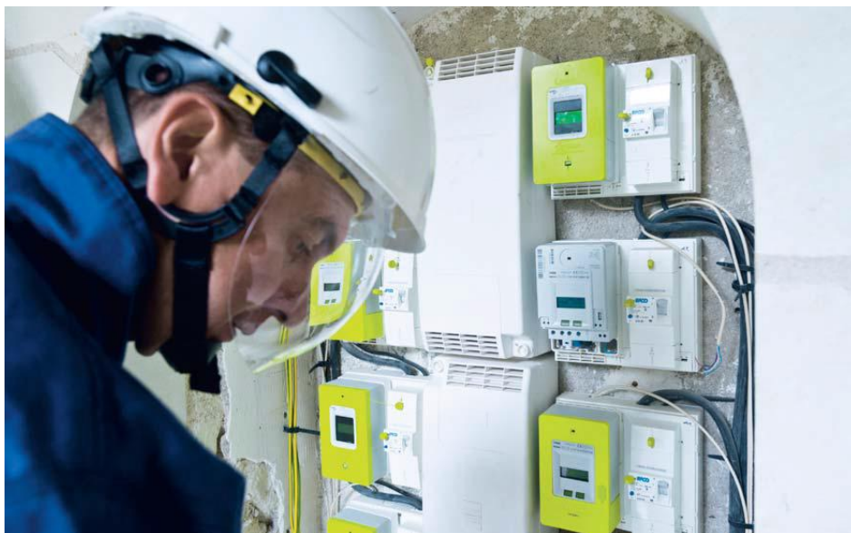
Technicien assurant une mise en service de compteurs
