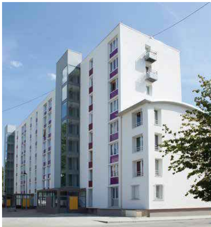
Résidence La Vigne Blanche - 486 logements, Les Mureaux (78)
