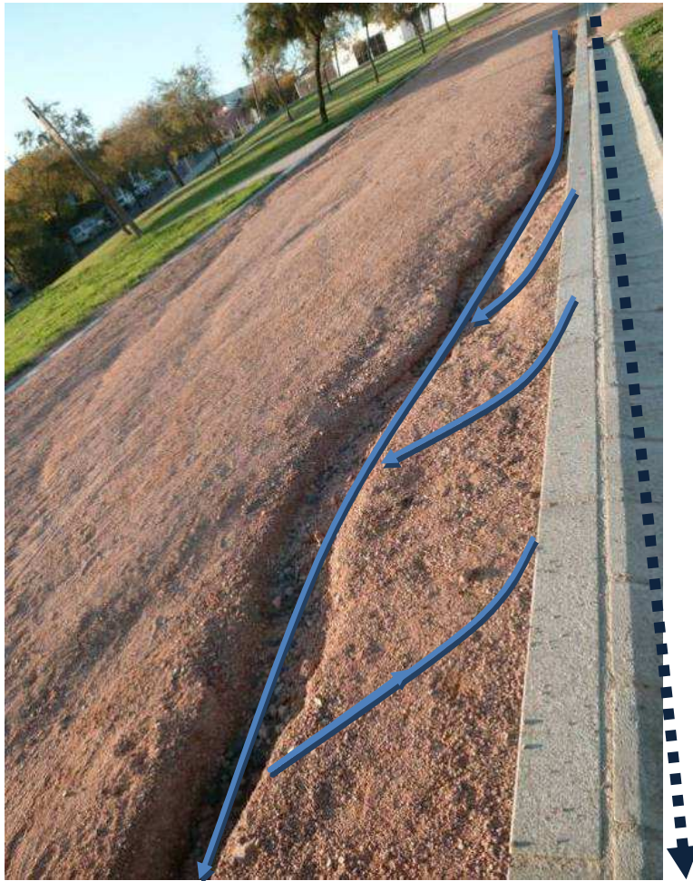
Figura 15: Análisis del camino de agua (2) , identificación de problemas de erosión Fuente: fotos personales y esquema de análisis.
