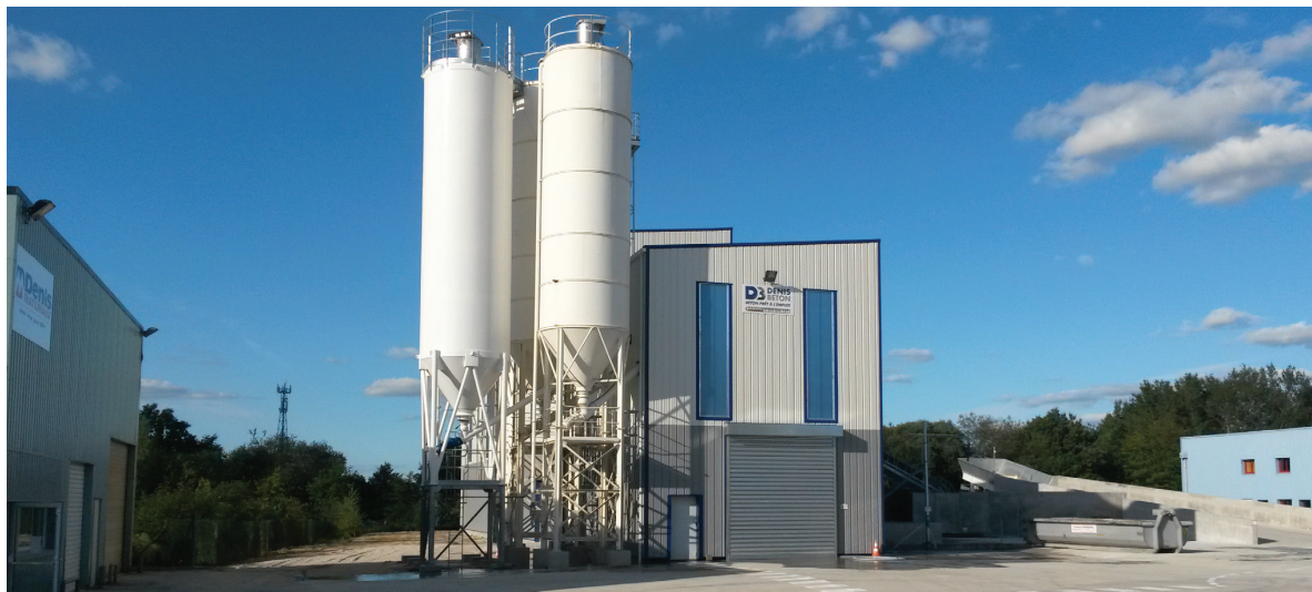
Centrale, la nouvelle unité de fabrication de béton de Bruz dessert neuf agences commerciales du groupe.
