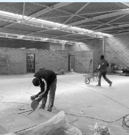
Ça avance bien. Même très bien ! Les cloisons ont déjà été montées.
