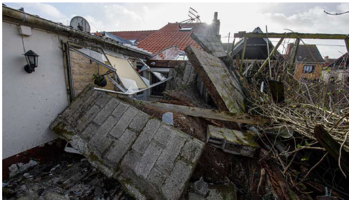
Le mur de la maison s'est effondré sur l'habitation voisine.
