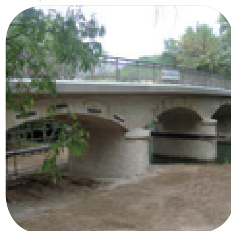
Réhabilitation du pont sur la Mosson, Grabels (34) Mosson bridge rehabilitation
