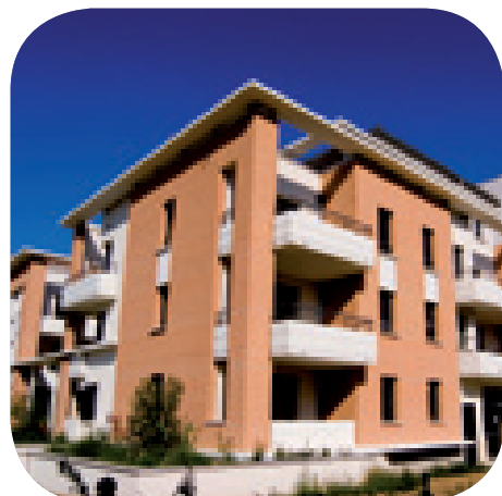
Résidence Côté Jardin , Colomiers (31) Arch. : ARUA Côté Jardin residence
