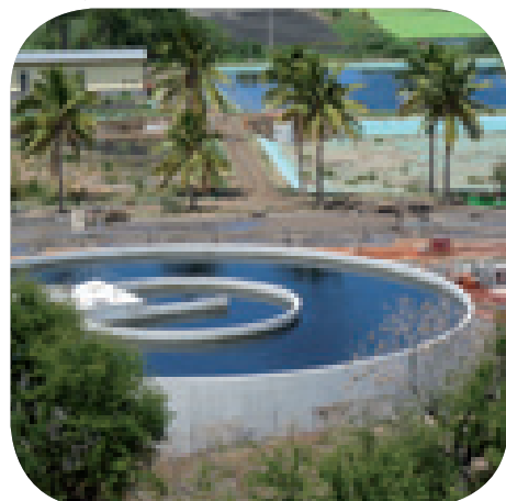
Station d'épuration de l'Hermitage, La Saline-les-Bains (Ile de la Réunion) Arch. : EGIS Eau Hermitage wastewater treatment plant
