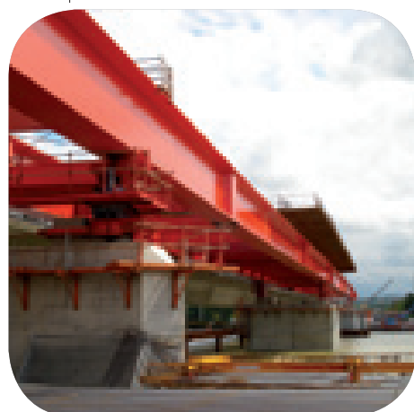
Viaduc sur l'Adour - A63, Bayonne (64) Adour Viaduct
