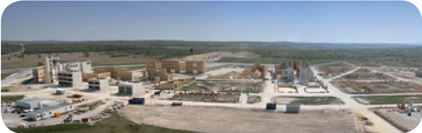
Infrastructure de tirs en zone urbaine, Sissonne (02) Arch. : Etablissement du Génie de Lille Infrastructure of urban fire
