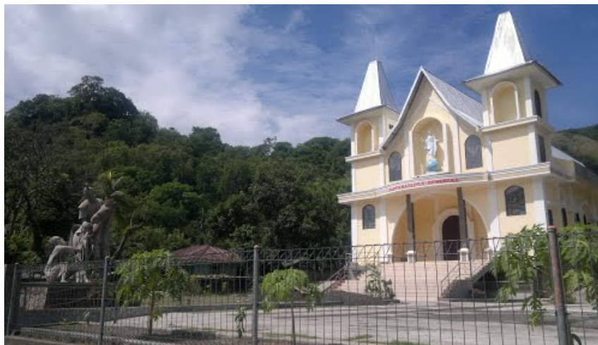
Figure 19 L'église Saint Martin à Roworeke Ende, Indonésie (Source : http://www.panoramio.com/m/photo/97301018 )
