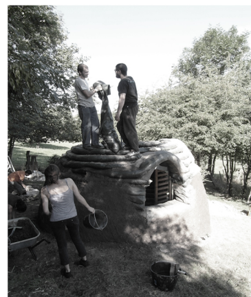
CONSTRUCTION D'UN ECO-DOME
