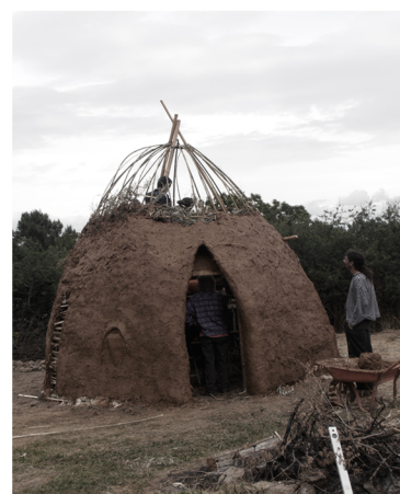
CONSTRUCTION D'UNE HUTTE EN BAMBOUS-TERRE
