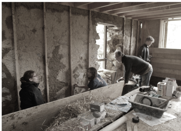
ISOLATION D'UN MUR EN PIERRE AVEC DE LA TERRE / PAILLE ALLEGEE
