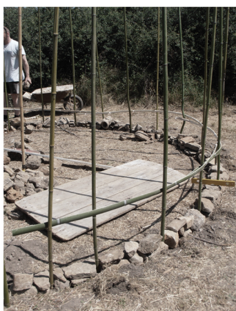
CONSTRUCTION D'UNE HUTTE EN BAMBOUS-TERRE
