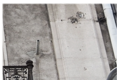
Purge des fers
