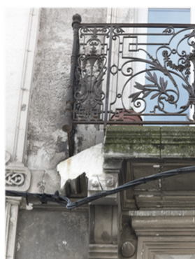
Reconstitution de l'angle d'un balcon cassé
