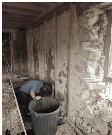
ISOLATION D'UN MUR EN PIERRE AVEC DE LA TERRE / PAILLE ALLEGEE
