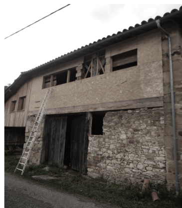
CONSTRUCTION D'UN MUR EN TERRE / PAILLE ALLEGEE
