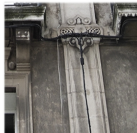
Retrait de fils électriques inutiles
