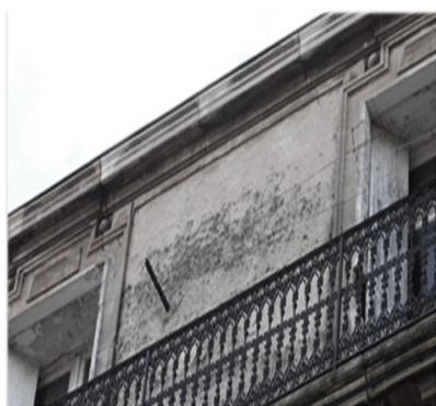
Rejointoiement des pierres de l'acrotère
