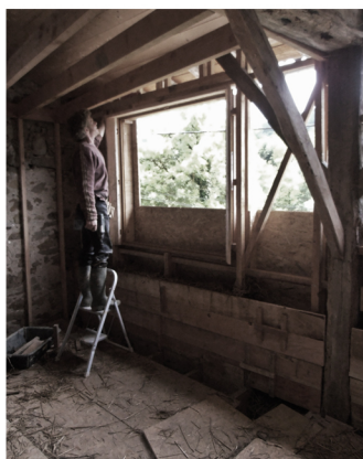
CONSTRUCTION D'UN MUR EN TERRE / PAILLE ALLEGEE
