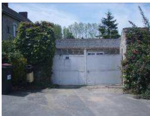
Figure 32 : photographie du portail d'accès au site par le parking de l'église Source : JCP mai 2008
