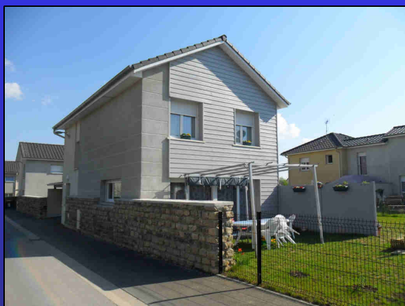
N°5 – Rue Manet : 14 logements avec garage et jardin (fini en Juin 2010)
