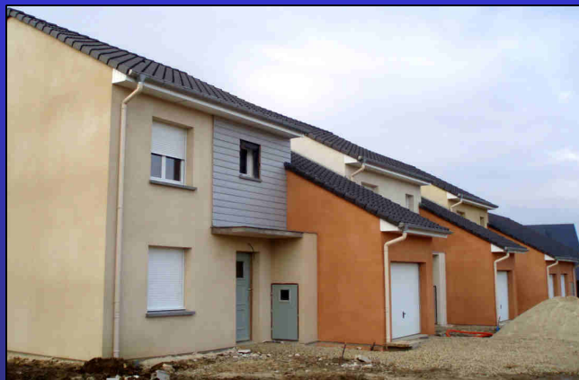
N°4 – Rues Ingres et Watteau : 16 pavillons (fini en Mars 2010)
