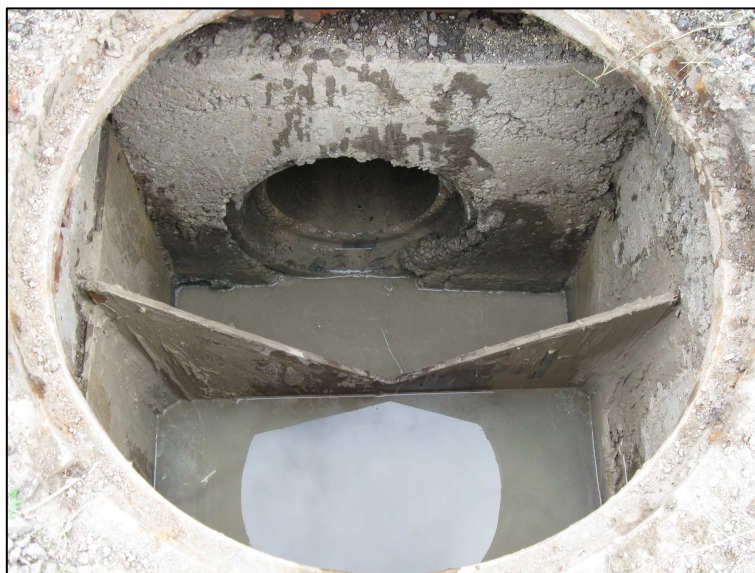
Photo n° 4 : Seuil venant d'être installé avec du « ciment prompt ».
