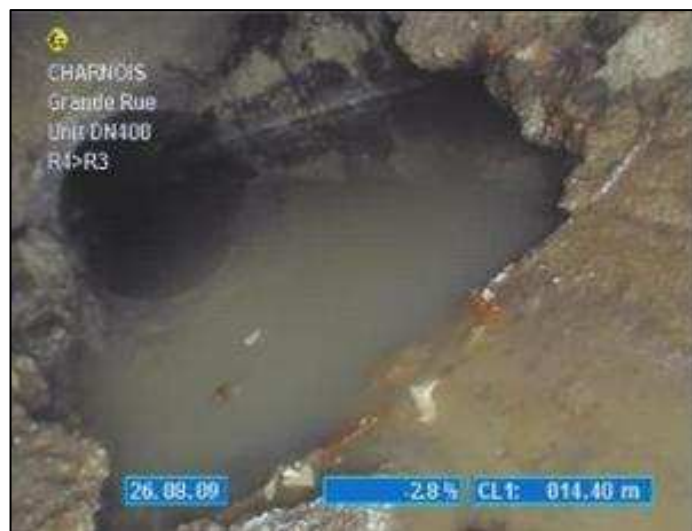
Photo n°2 : Abrasion au radier.
