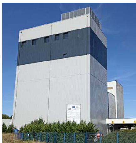
Après 18 mois de travaux, Iris s'élève sur 44 m de haut et 3 600 m 2 (31 m de long et 20 m de large). Sa construction a nécessité 10 000 t de béton et 450 t de ferraille.
