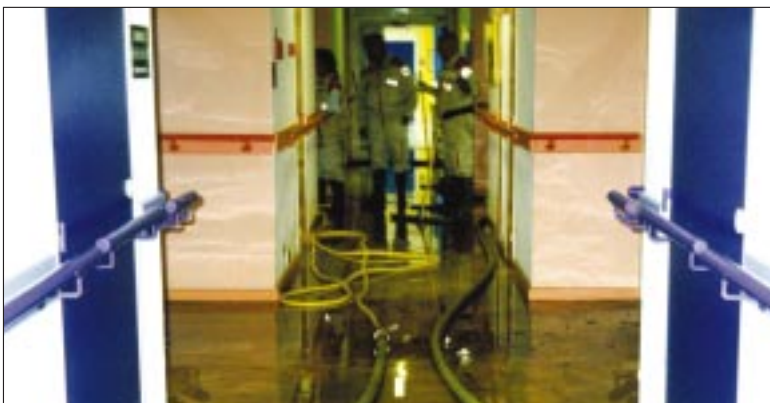
▲ Aux Lavandines, l'eau est montée à 8 centimètres inondant le rez-de-chaussée de la résidence.
