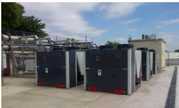
Groupes de froid des systèmes Drypack Plus
