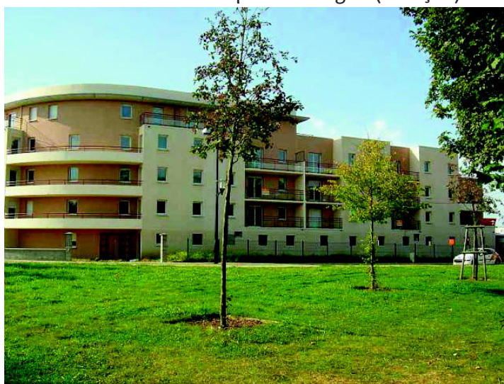
La résidence Pénélope à Perseigne (Alençon)
