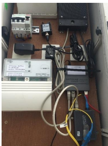
Figure 18 : Exemple d'un boîtier CPL sur le réseau de la SERC
