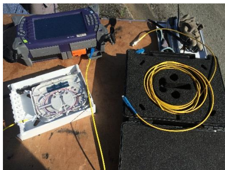
Figure 31 : Boitier avec soudure rangée – Réflectomètre pour vérifier la soudure – Amorce de 1km de fibre optique
