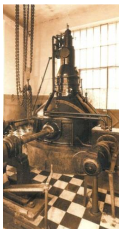
Figure 2 : Ancienne centrale de production d'énergie hydraulique
