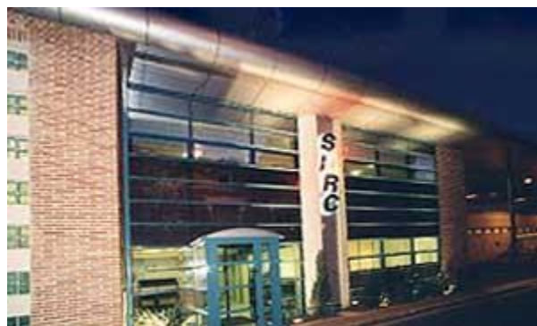
Figure 5 : Photo de la façade des bureaux
