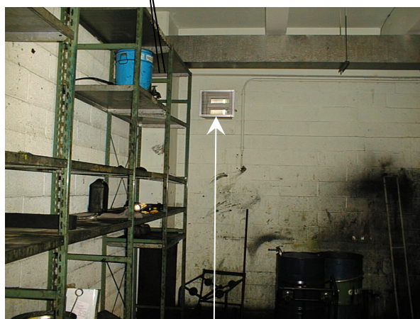
C.C.F. de transfert à déposer et calfeutrer
