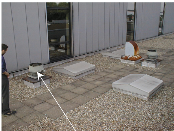
Tourelle d'extraction à démonter
