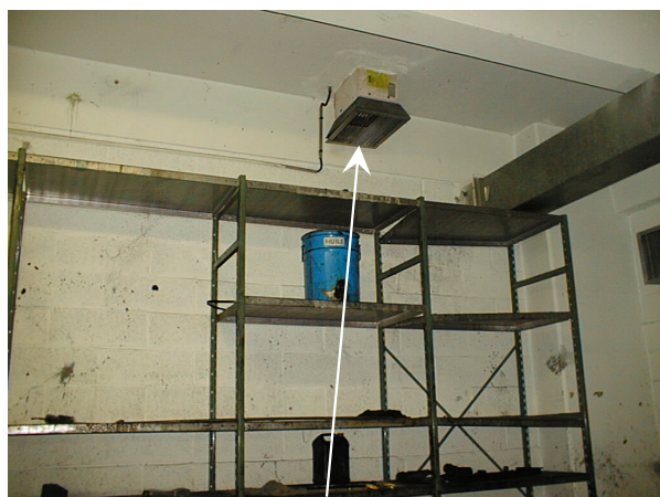
Clapet coupe-feu à déposer
