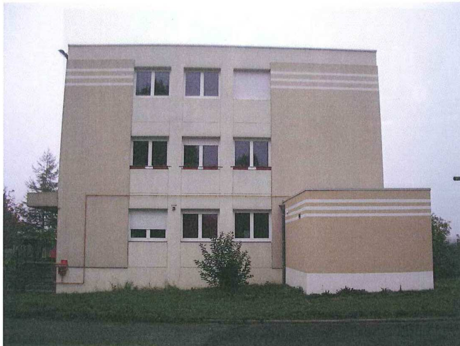
Logements de fonction et sa chaufferie géothermie
