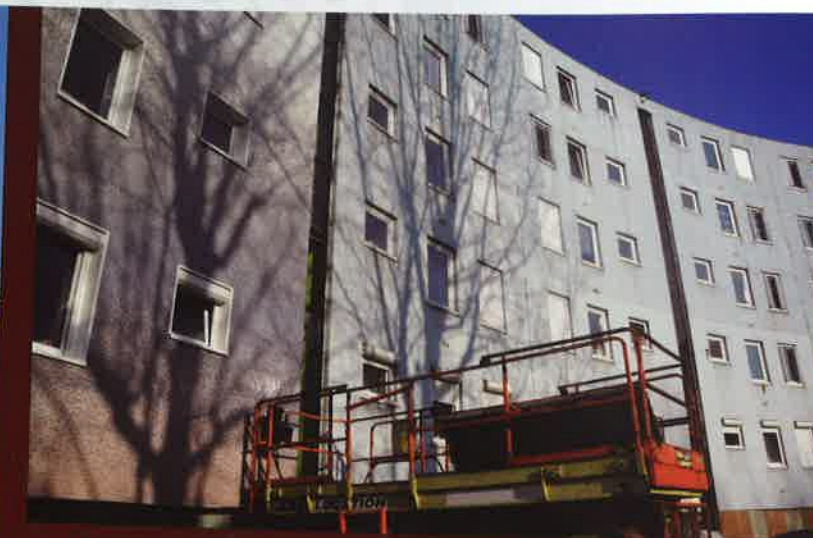
Les bâtiments du Serpentin datant de 1954 ont reçu une isolation thermique extérieure qui respecte l'aspect d'origine avec ses petits carreaux de verre en façade.
