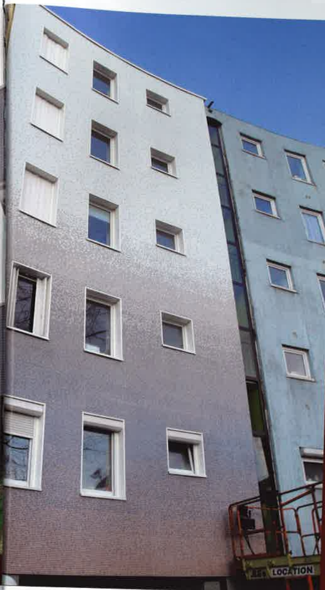
Les bâtiments du Serpentin datant de 1954 ont reçu une isolation thermique extérieure qui respecte l'aspect d'origine avec ses petits carreaux de verre en façade.
