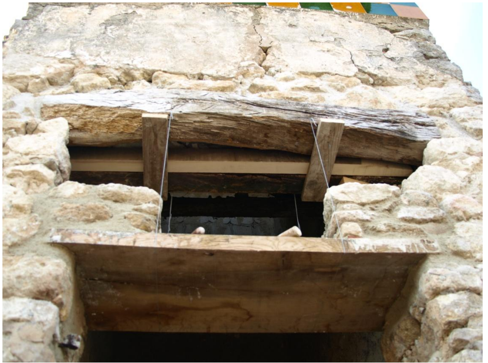
Mise en attente d'une pièce en frêne derrière le linteau. Début de maçonnerie de moellons.
