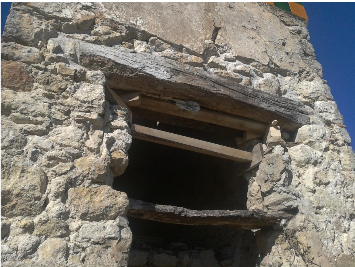
Nettoyage de la partie basse et mise en sécurité de la partie supérieure.
