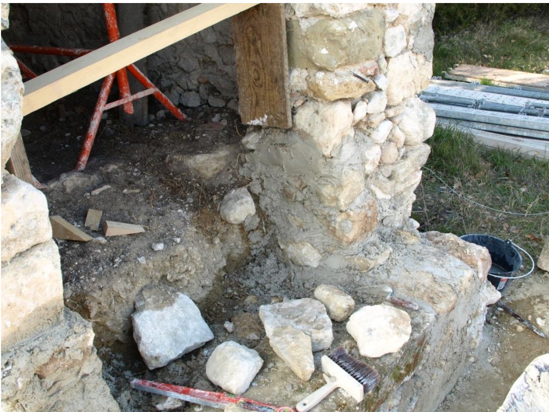
Consolidation des bases des jambages.
