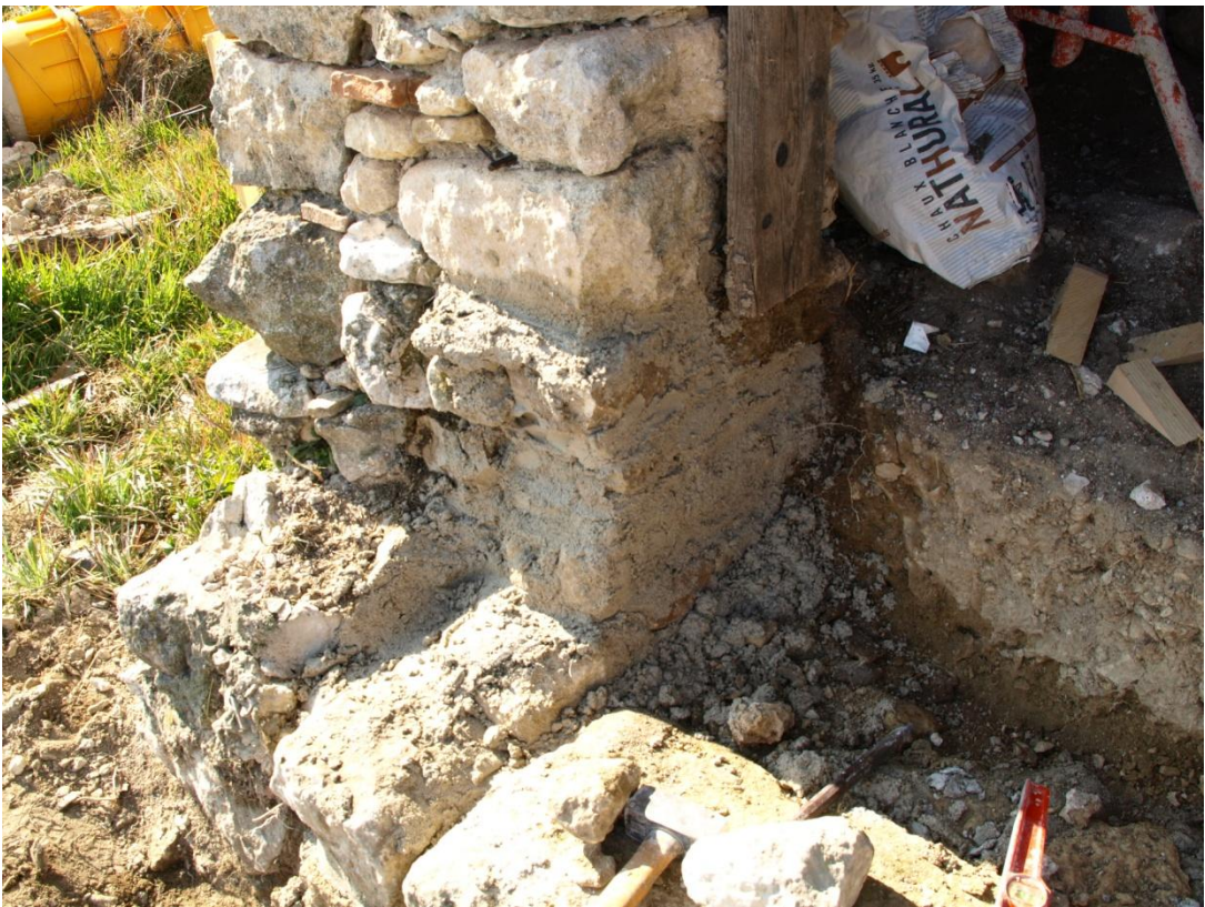
Consolidation des bases des jambages.
