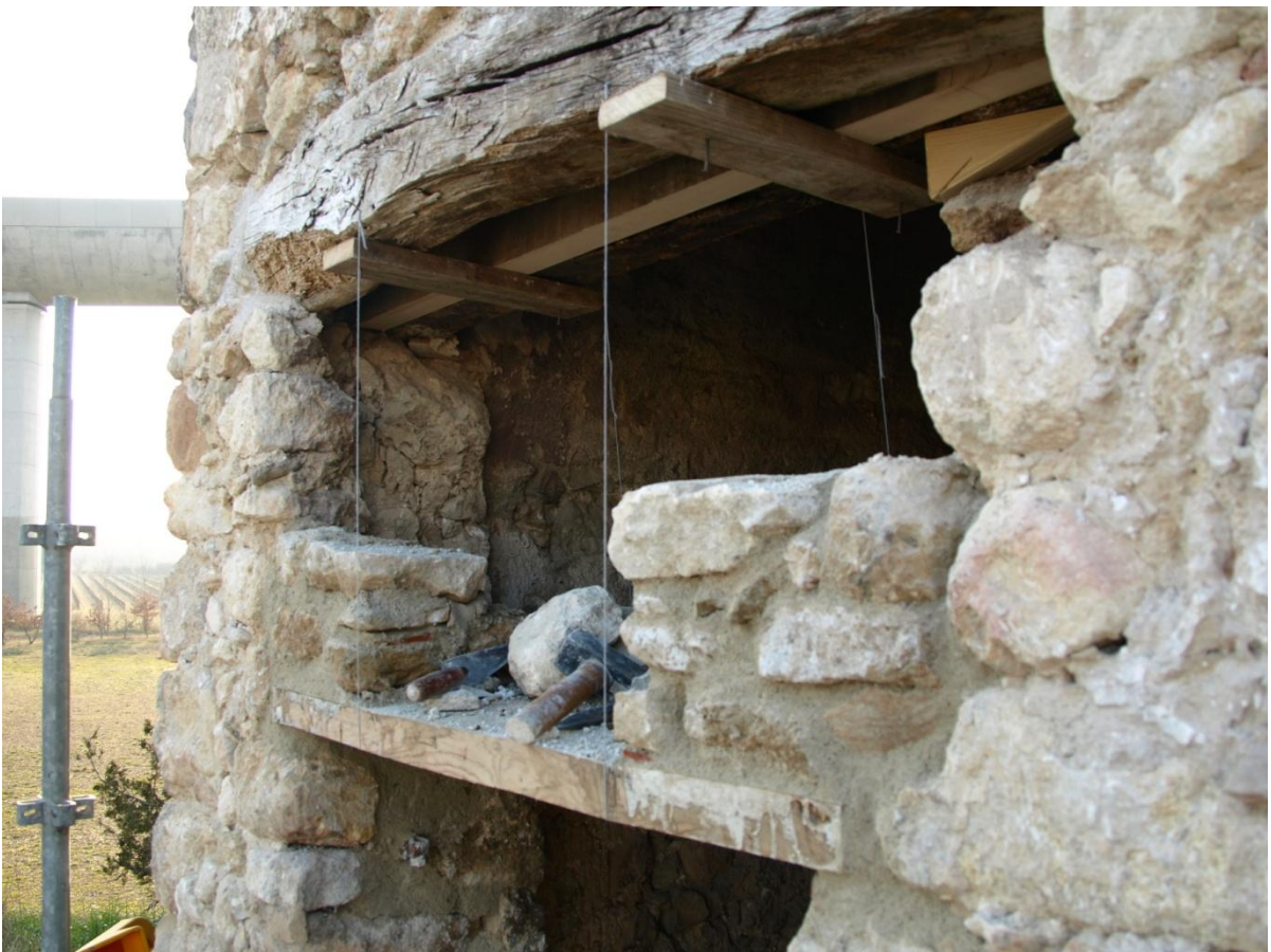
Mise en attente d'une pièce en frêne derrière le linteau. Début de maçonnerie de moellons.
