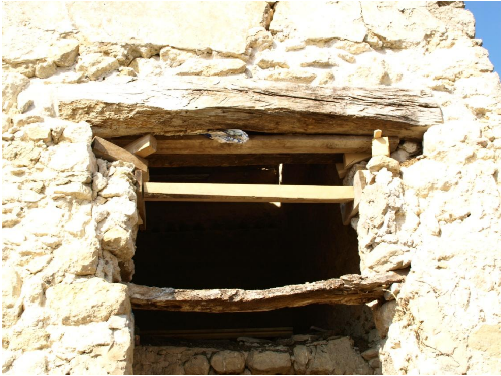
Etat de la partie supérieure avant intervention.
