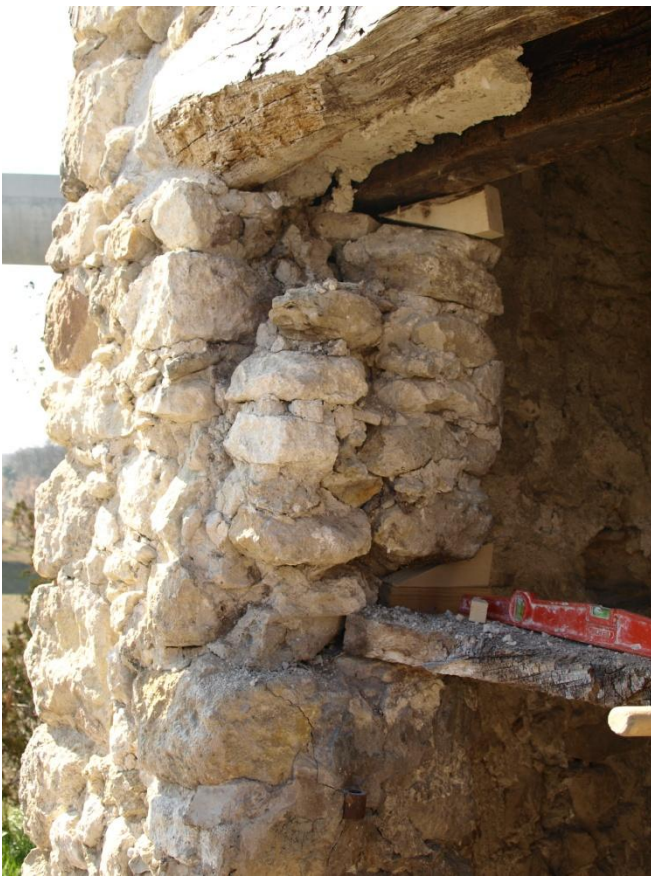
Mise en place de l'échafaudage. Etat de la maçonnerie avant et après la purge.
