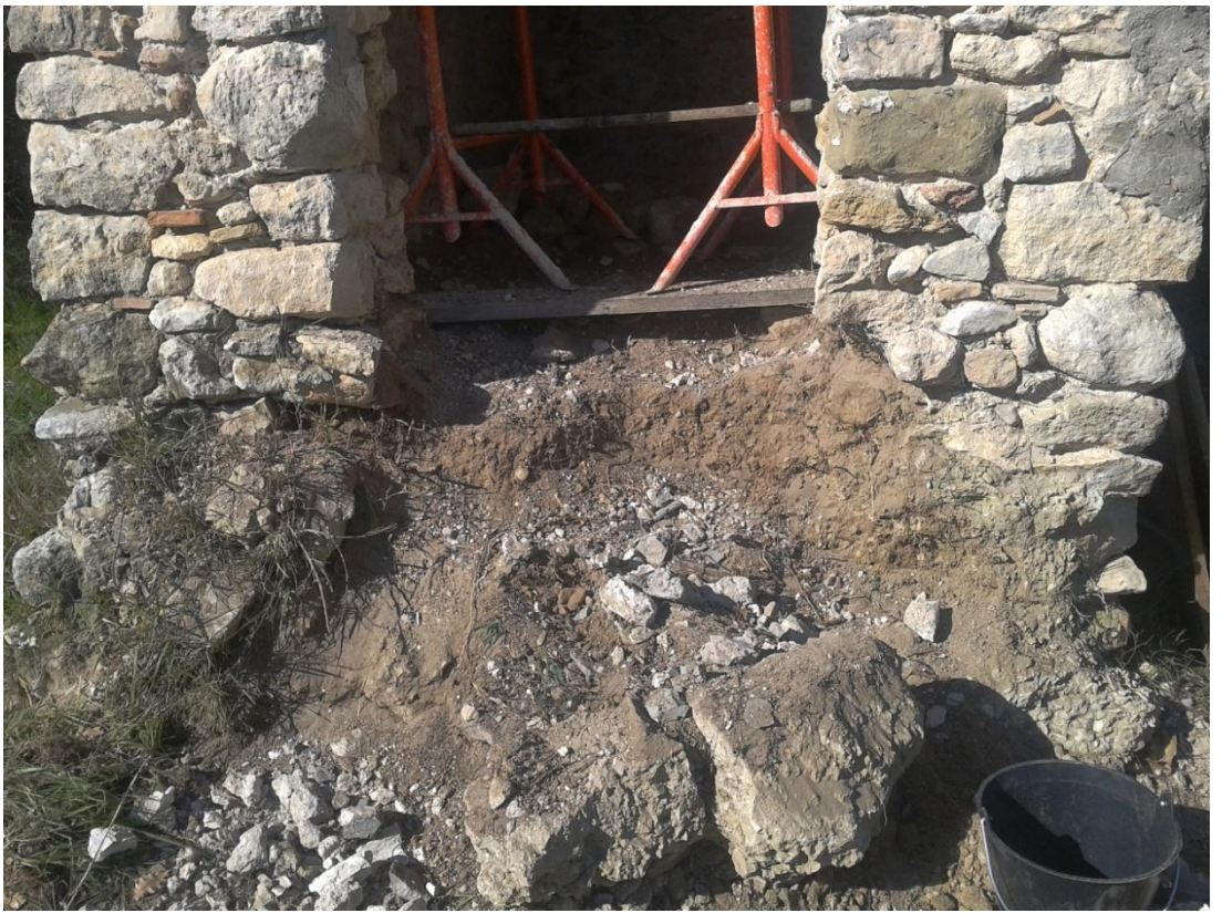
Nettoyage de la partie basse et mise en sécurité de la partie supérieure.
