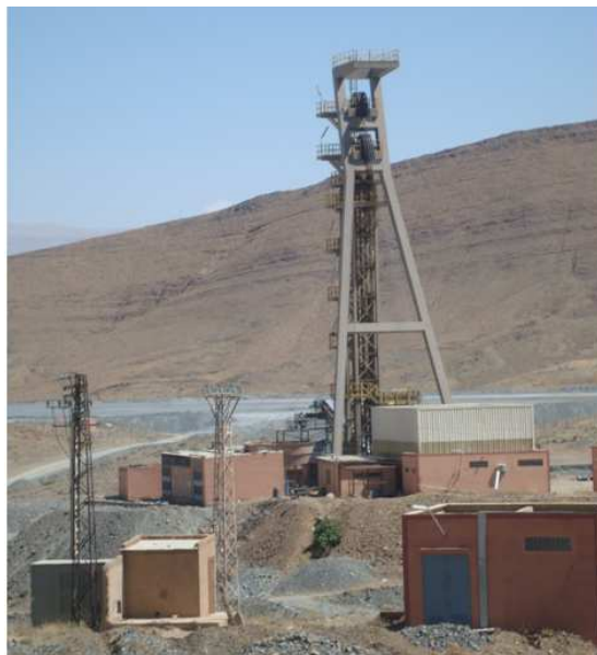
Figure 5 : La machine d'extraction de puits central.
