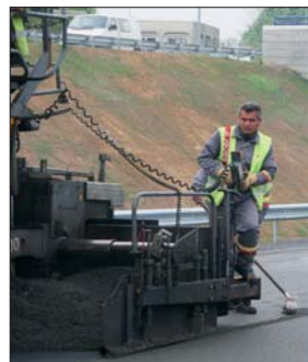
Les cent derniers mètres du contournement Nord ont été réalisés à partir d'un enrobé avec revêtement végétal.
