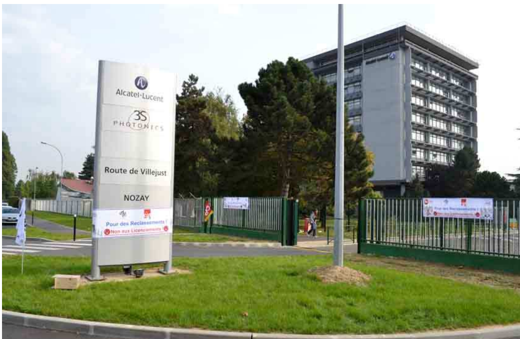
Image [4] : La Tour centrale sur le site de Villarceaux à Nozay.
