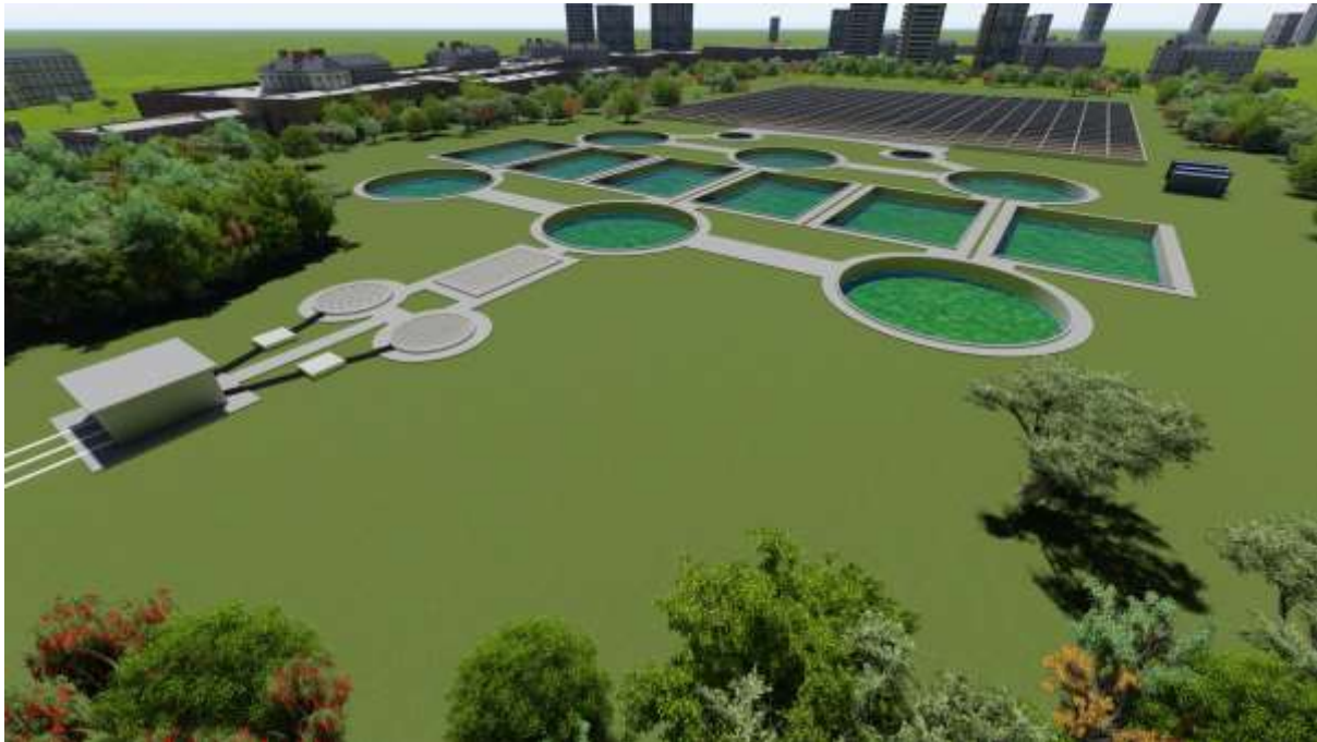
Figure 3: Station à boue activée projetée
